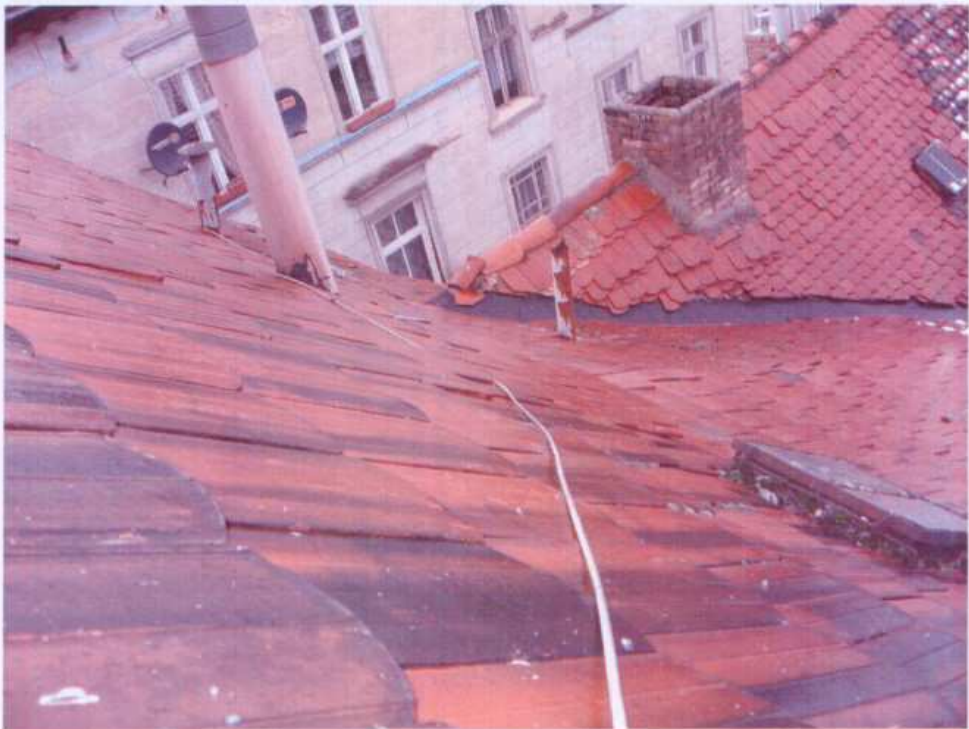
Fot. 8. Pokrycie dachowe oficyny
