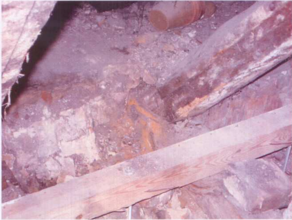
Fot. 7. Konstrukcja dachowa oficyny- połączenie krokwi z belką stropową
