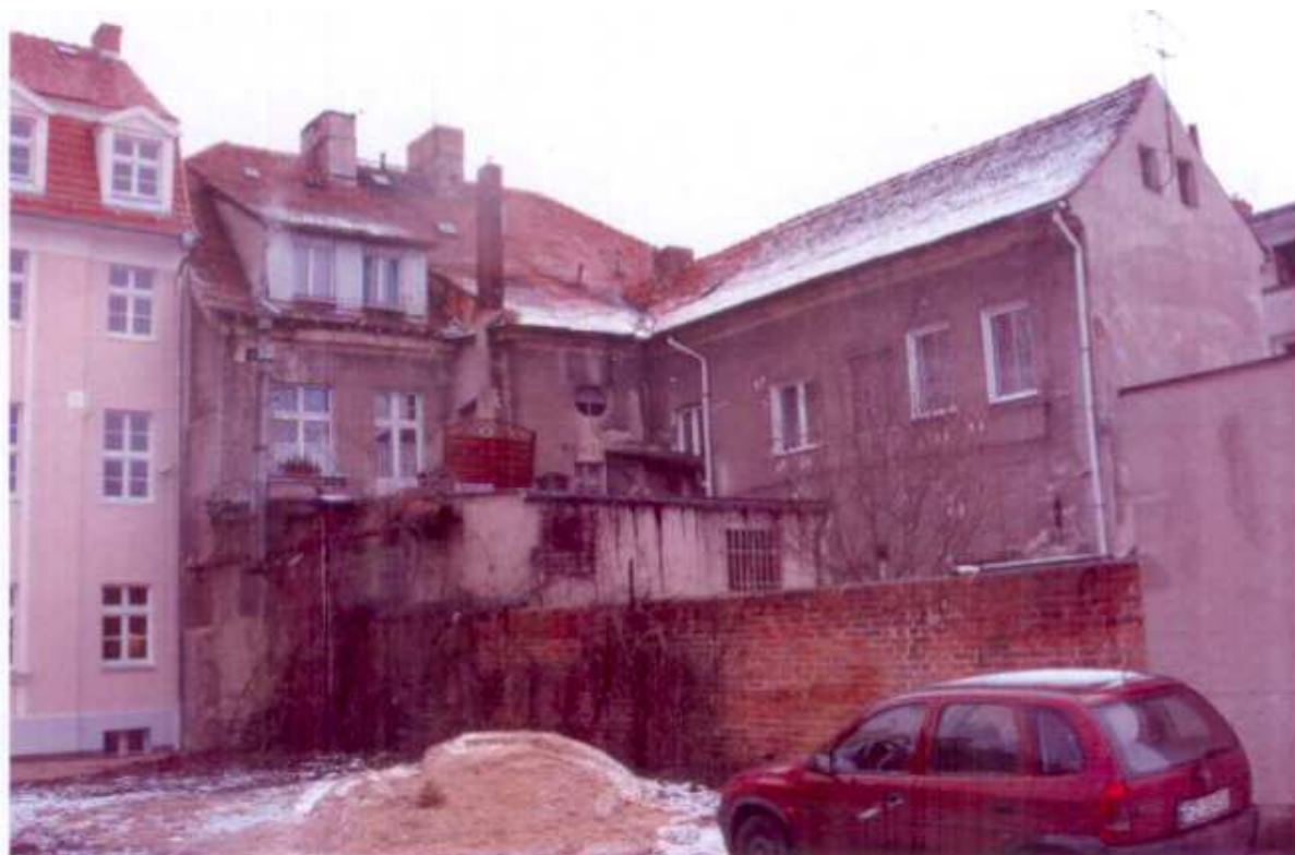
Fot. 4. Elewacje budynku od strony podwórza (wschodnia i południowa)
