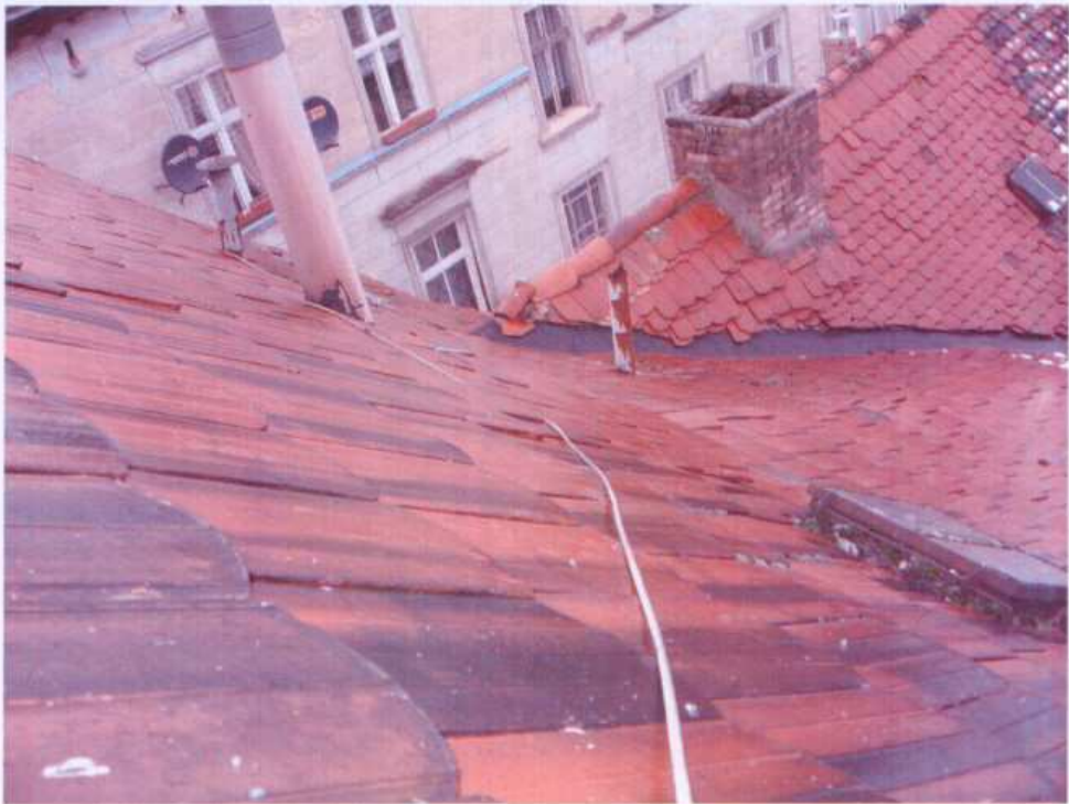
Fot. 8. Pokrycie dachowe oficyny
