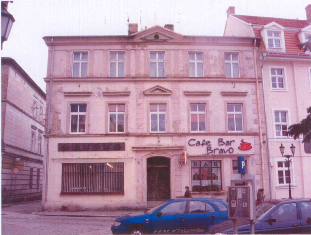
Fot. 1. Elewacje frontowa - zachodnia
